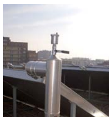
Purgador automático con válvula (izq) y dos sistemas de purga manual
