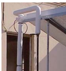
Purgador automático con válvula (izq) y dos sistemas de purga manual
