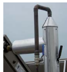
Purgador automático con válvula (izq) y dos sistemas de purga manual
