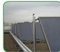
Figura 2. Colectores solares planos instalados en cubierta.
