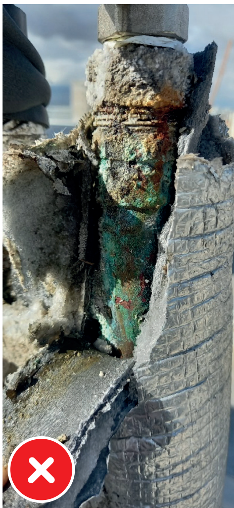
Aislación y cañería afectadas por condiciones ambientales.
