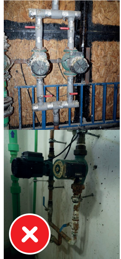
Bombas hidráulicas con presencia de suciedad y sarro, y tuberías adyacentes con aislamiento térmico deficiente.
