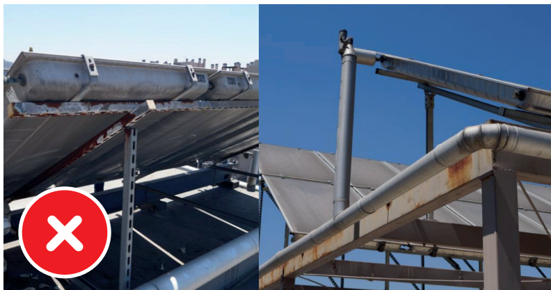
Estructuras que no respeta norma NCh 1079.
