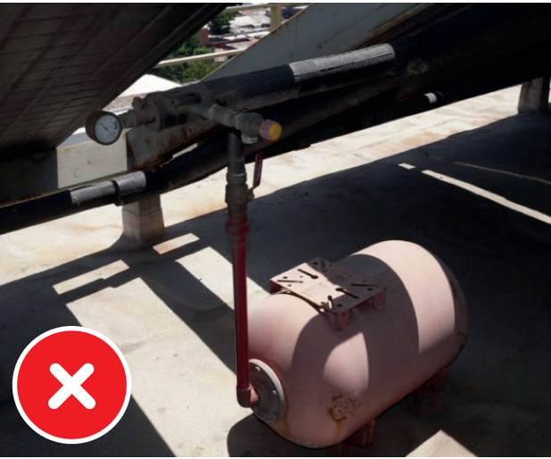
Vaso de expansión a la intemperie sin protección frente a los agentes ambientales, incorrectamente instalado y sin elementos de seguridad.
