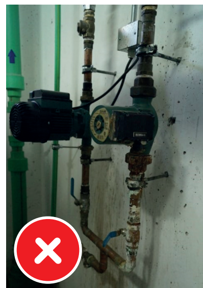
Bombas mal diseñadas y sin aislación térmica.
