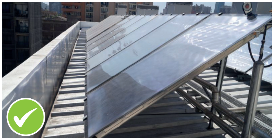
Sistema de captación correctamente instalado en cuanto a orientación e inclinación.
