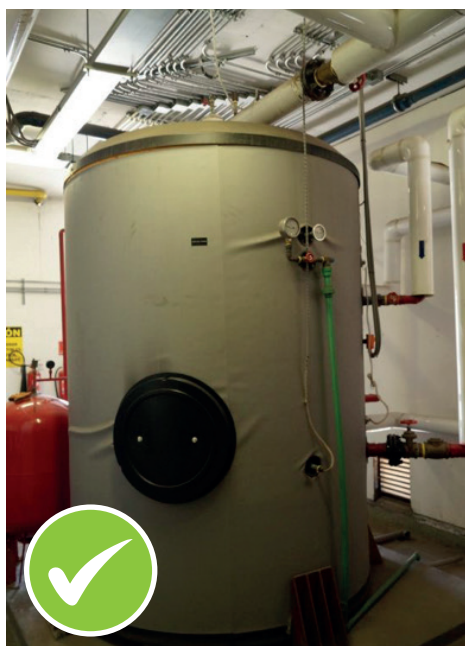
Aislación y cañería afectadas por condiciones ambientales.
