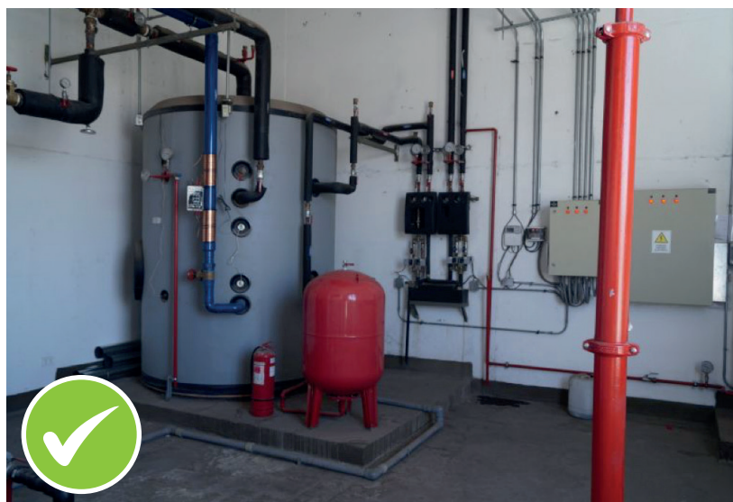
Acumulador con aislación térmica en condiciones adecuadas, y con correcta distribución de componentes dentro de sala técnica.
