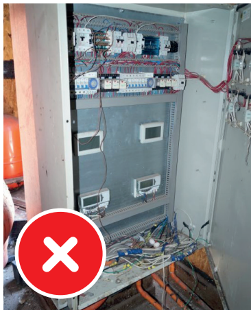
Cuadro eléctrico fuera de norma.
