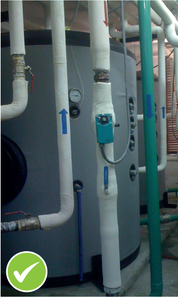
Tuberías correctamente aisladas, donde se indica el sentido del flujo de agua fría y caliente.
