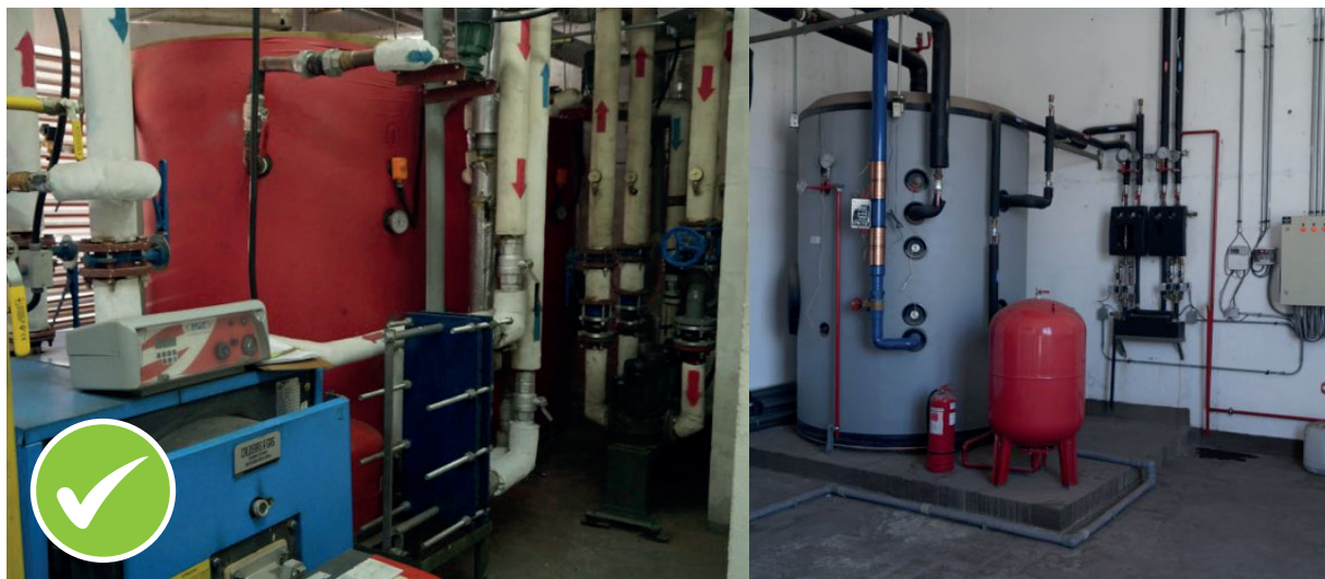
Componentes instalados en sala técnica con acceso restringido a personal no autorizado.
