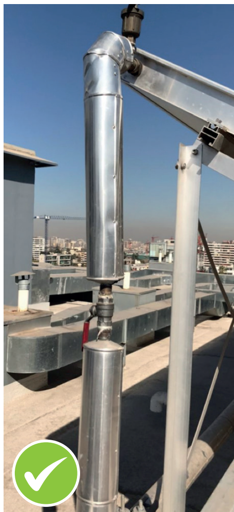
Instalación protegida de condiciones externas que generan corrosión y deterioro de material.
