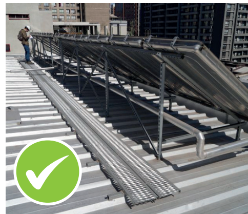
Estructura conforma a norma NCh 1079.
