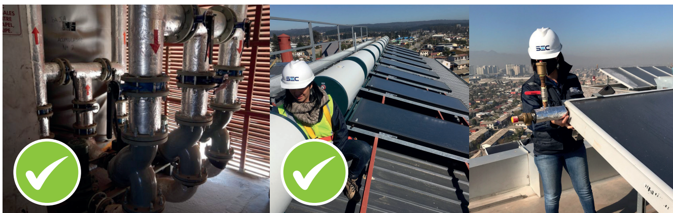
Tuberías con flechas de sentido de flujo y acumulador con nombre etiquetado.
