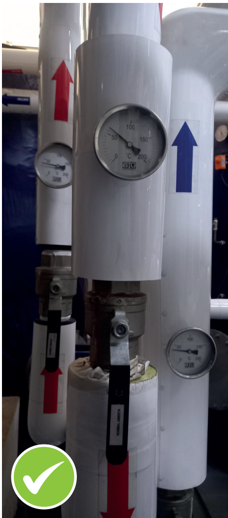
Sistemas de medición de temperatura apropiados.
