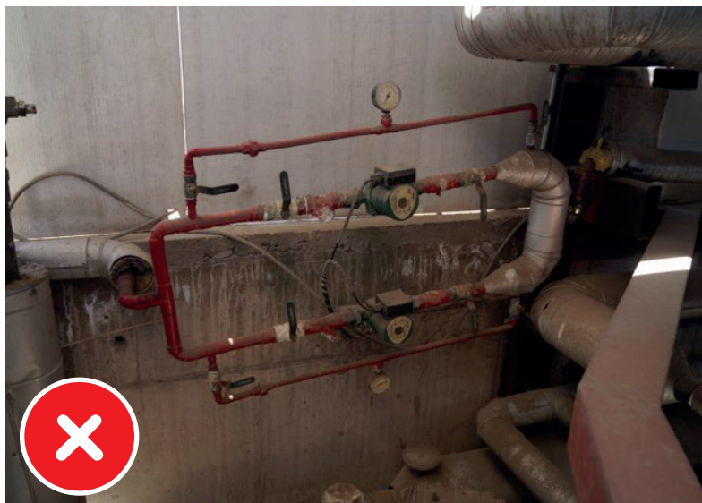
Cañerías mal diseñadas y precariamente mantenidas.
