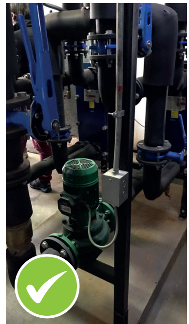
Bomba hidráulica en condiciones óptimas dentro de sala técnica, montadas sobre nivel.
