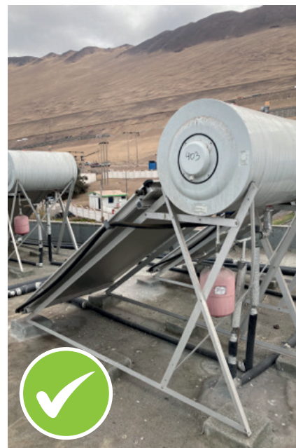
Sistemas prefabricados con estructura de soporte y sujeción adecuados.
