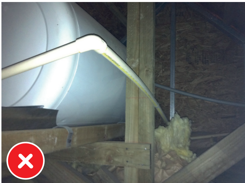
Inadecuado posicionamiento del DA y estructura de soporte y sujeción de materialidad incorrecta.
