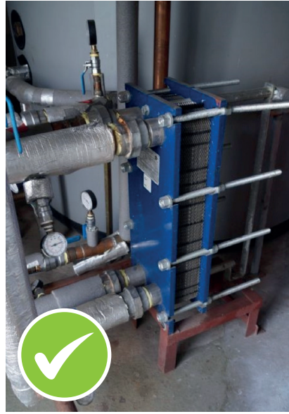
Cañerías adyacentes a intercambiador con aislación térmica en condiciones óptimas.
