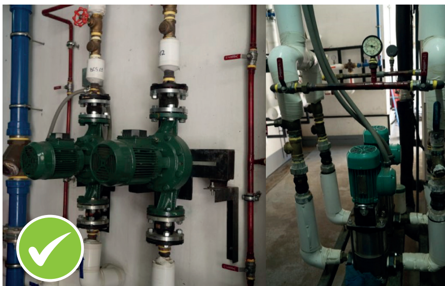
Bombas correctamente instaladas y con aislación térmica en buenas condiciones.
