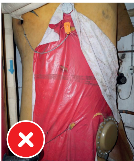
Acumulador con aislamiento térmico deteriorado y deficiente.
